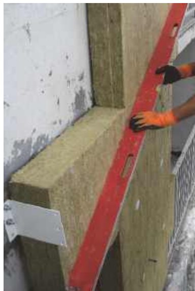
Рис. 5.15. Контроль якості приклеєних плит
