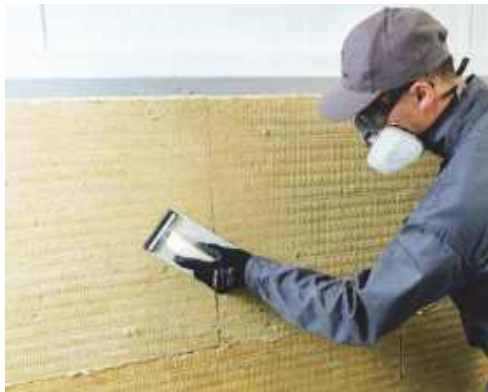
Рис. 5.16. Затирання (шліфування) швів
