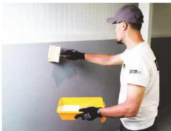
Рис. 5.4. Грунтування поверхні стіни закріплювальною ґрунтівкою ThermoELF «UniGrund»
