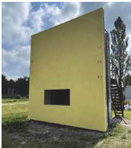
Рис. А.1. Витяг із Протоколу № 97/1-2022. Фрагмент будинку зі збіркою системою фасадної теплоізоляції «ThermoELF» перед випробуванням на пожежно-випробувальному полігоні НДЦ «Пожежна безпека», Київська обл.
