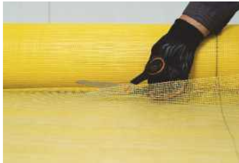
Рис. 5.22. Розрізання склосітки ThermoELF «Gewebe 160»
