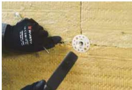
Рис. 5.19. Улаштування дюбеля в отвір: а – установлення пластикової тарілчастої «гільзи» дюбеля; б – убивання розпірного елемента в «гільзу» дюбеля
