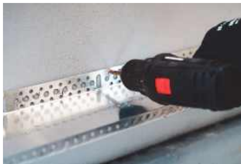
Рис. 5.6. Фіксація напрямного профілю ThermoELF «Sokelchne»
