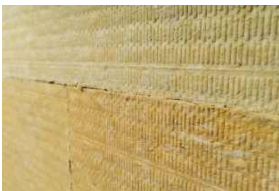
Рис. 5.13. Перев'язка плит утеплювача: а – на кутах; б – уздовж стіни
