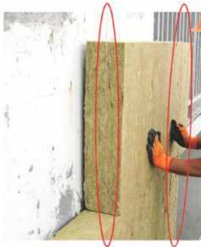
Рис. 5.5. Укладання елементів утеплення з орієнтуванням на вертикальні шнури (обведені червоними контурами)
