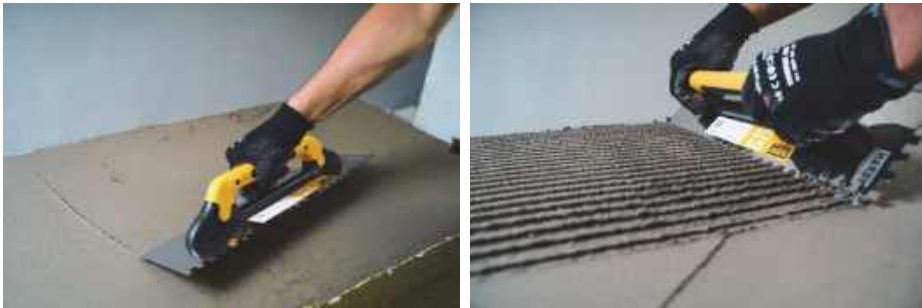
Рис. 5.8. Суцільний спосіб нанесення клейової розчинової суміші на плиту утеплювача, де: а) схематичне зображення, де: 1 – клейовий розчин; 2 – плита утеплювача; б) розрівнювання клею та створення борозенок зубчастим шпателем
