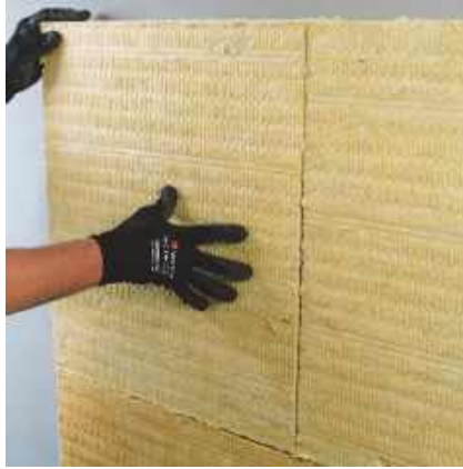
Рис. 5.12. Притискання плити утеплювача до основи
