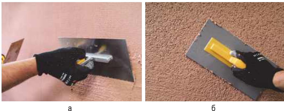
Рис. 5.27. Улаштування штукатурного шару: а – нанесення штукатурної розчинової суміші на основу; б – формування фактури типу «баранець»
