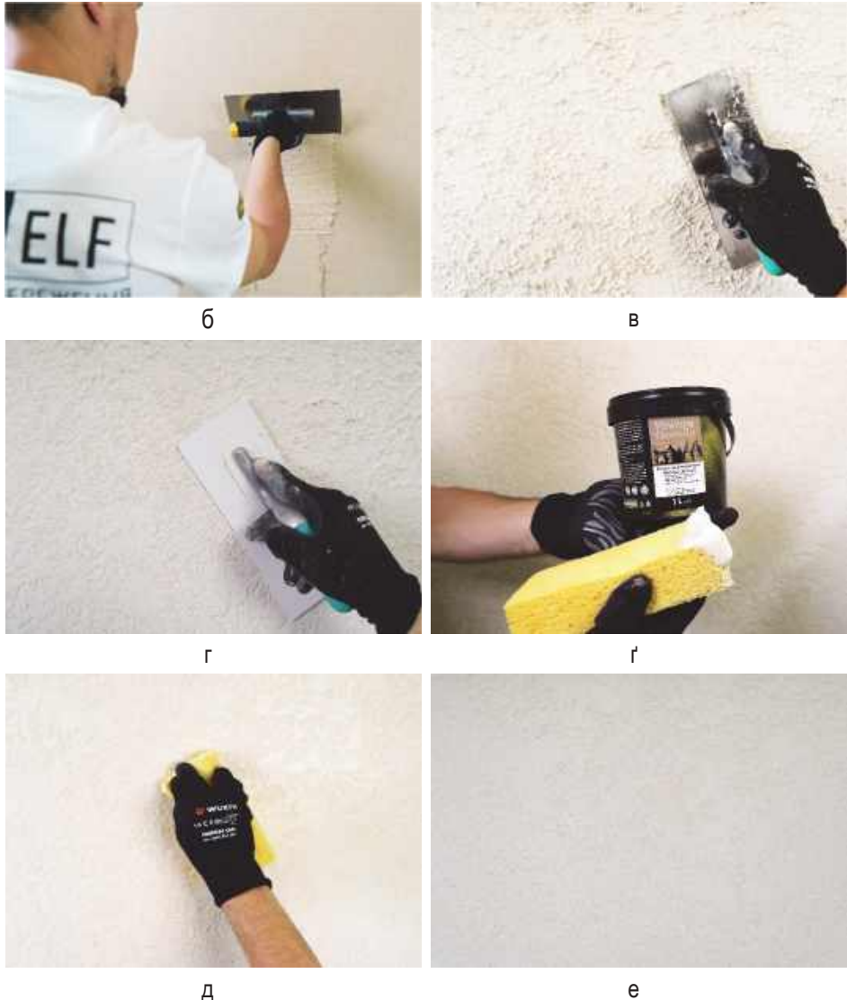
Рис. 5.30. Створення фактури з імітацією природного каменю за допомогою декоративної тонкошарової штукатурки ТМ «Elf Decor»: а – нанесення штукатурки на терку із нержавіючої сталі; б – нанесення штукатурки на поверхню; в – перший етап формування фактури з імітацією природного каменю – створення «ніжки»; г – другий етап формування фактури з імітацією природного каменю – пригладжування поверхні; ґ – третій етап формування фактури з імітацією природного каменю – нанесення воску на губку; д – четвертий етап формування фактури з імітацією природного каменю – втирання воску в поверхню; е – готова поверхня
