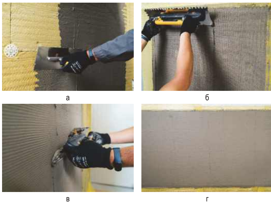
Рис. 5.25. Послідовність улаштування захисного шару: а – нанесення клейової розчинової суміші на утеплювач; б – утоплення склосітки в клейовий шар; в – нанесення клейової розчинової суміші на склосітку; г – готовий захисний шар
