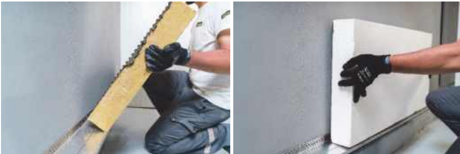
Рис. 5.11. Приклеювання плит утеплювача першого ряду
