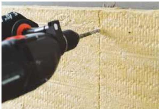
Рис. 5.18. Просвердлювання отворів для механічної фіксації утеплювача
