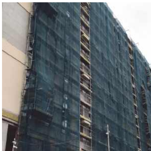
Рис. 5.33. Загальний вигляд утеплення фасадів з універсальних риштувань: а – без навішування сітки; б – з завішуванням сіткою
