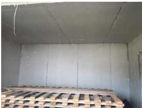
Рис. А.2. Витяг із Протоколу № 97/1-2022. Модель внутрішнього приміщення – «вогнева камера», оздоблена збірною системою фасадної теплоізоляції
