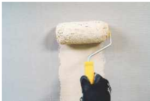
Рис. 5.26. Ґрунтування поверхні за допомогою валика: а – порційне наливання затонованої ґрунтувальної фарби в малярний лоток; б – нанесення ґрунтувальної фарби за допомогою валика
