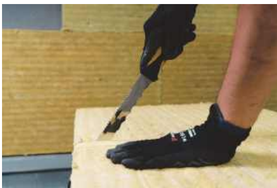
Рис. 5.14. Різання плит утеплення
