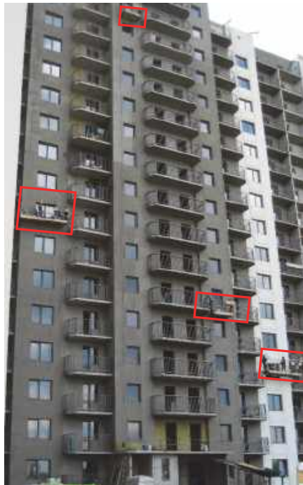
Рис. 5.31. Загальний вигляд утеплення фасадів із колісок
