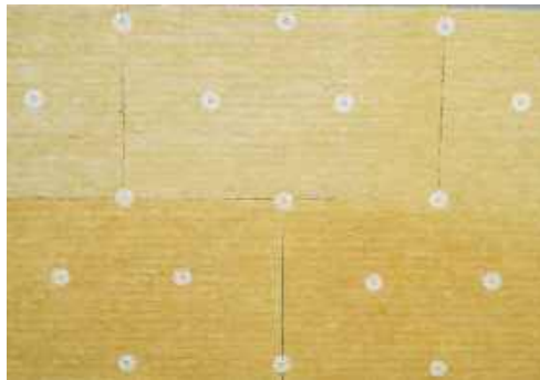
Рис. 5.20. Схема розміщення дюбелів під час кріплення мінераловатних плит
